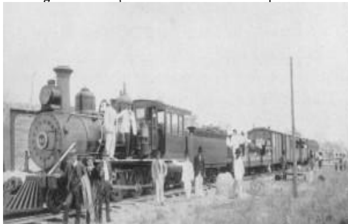
Figura 2 – Estação Ferroviária – NOB – Aquidauana.
