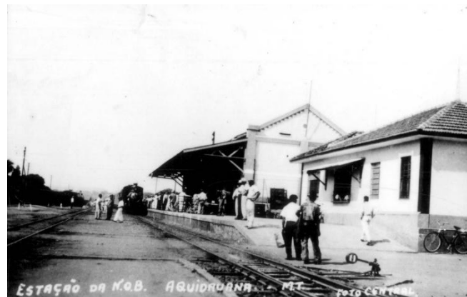
Figura 1 – Estação Ferroviária – NOB – Aquidauana.
