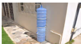
Figura 2. Água do ar condicionado sendo depositada no galão.
